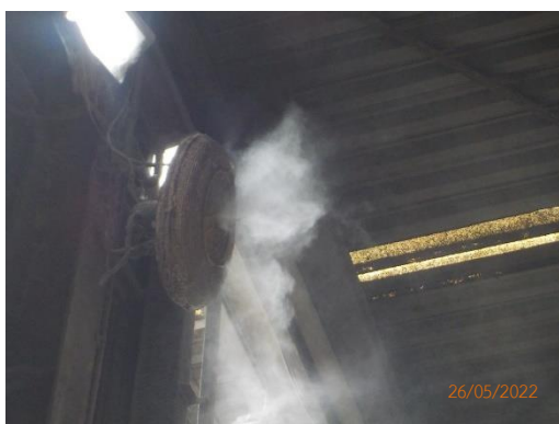
รูปที่ 2-3 ระบบฉีดพ่นเพื่อดับกลิ่นและฝุ่นละออง (Master Cool)
