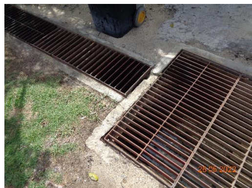
รูปที่ 2-27 บ่อพักน้ำฝน
