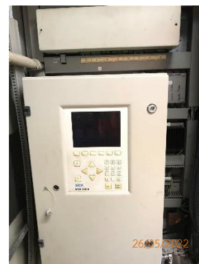
รูปที่ 2-15 ระบบ CEMS ของโครงการฯ
