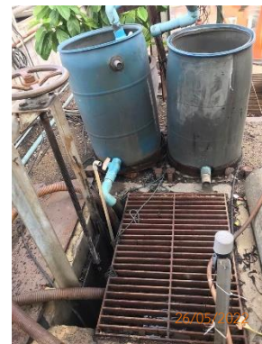
รูปที่ 2-23 ระบบถังกรองทราย (บ่อพักน้ำฝน)
