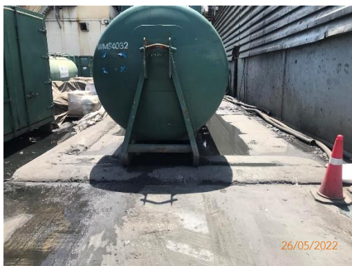
รูปที่ 2-26 คันคอนกรีต (บริเวณพื้นที่เก็บของเสียที่เป็นของเหลวไม่อันตราย)
